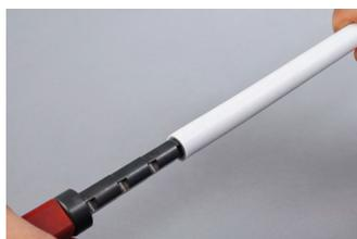
Sbavare e calibrare la superficie interna del tubo utilizzando l'apposito utensile (verificando la corrispondenza tra la misura della fresa utilizzata e la misura del tubo).
